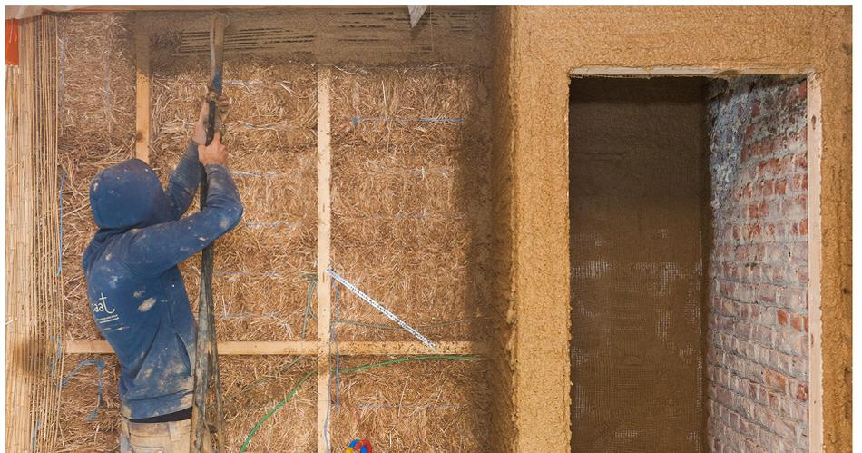
Enduit d'argile de Léém' appliqué à l'aide d'une machine à projeter sur des lattes de roseaux, des bottes de paille et de la maçonnerie.
