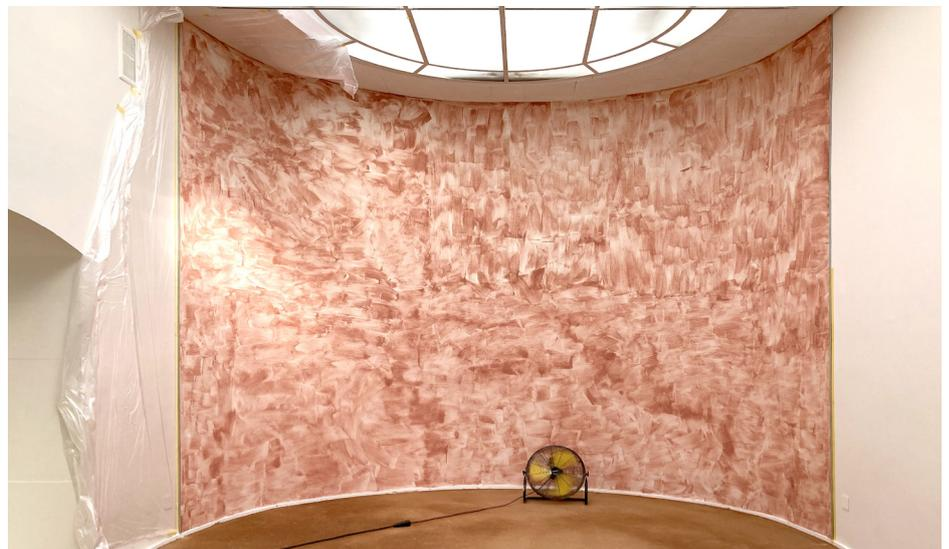
Un substrat de gypse existant préparé avec un primaire d'accrochage pour permettre au Enduit d'argile de Léém de s'ancrer correctement sur le mur.
