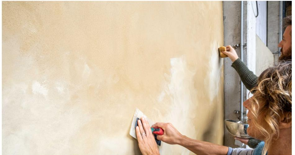
L'utilisation d'une truelle flexible en plastique permet d'obtenir une surface lisse et polie.
