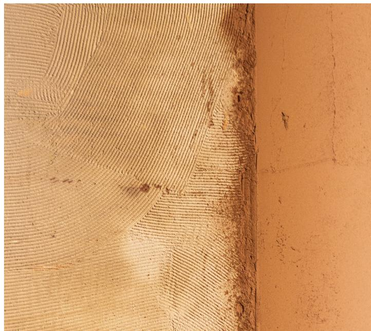
Enduit d'argile de Léém Brun en couche de fond en texture rugueuse, avec Enduit d'argile de Léém Rouge en couche de finition.
