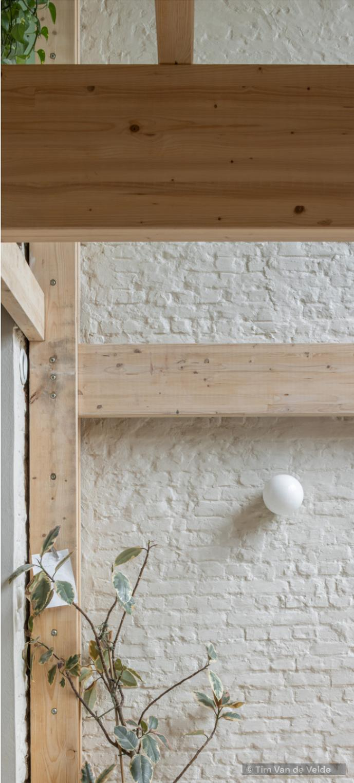
Peinture à l'argile Léém crème appliquée sur un mur en briques existant. En guise de préparation, on a vérifié que le mur était sec, ferme et dépoussiéré. Aucun apprêt ou fixateur n'a été utilisé. La peinture est appliquée en deux couches à l'aide d'un pinceau.
