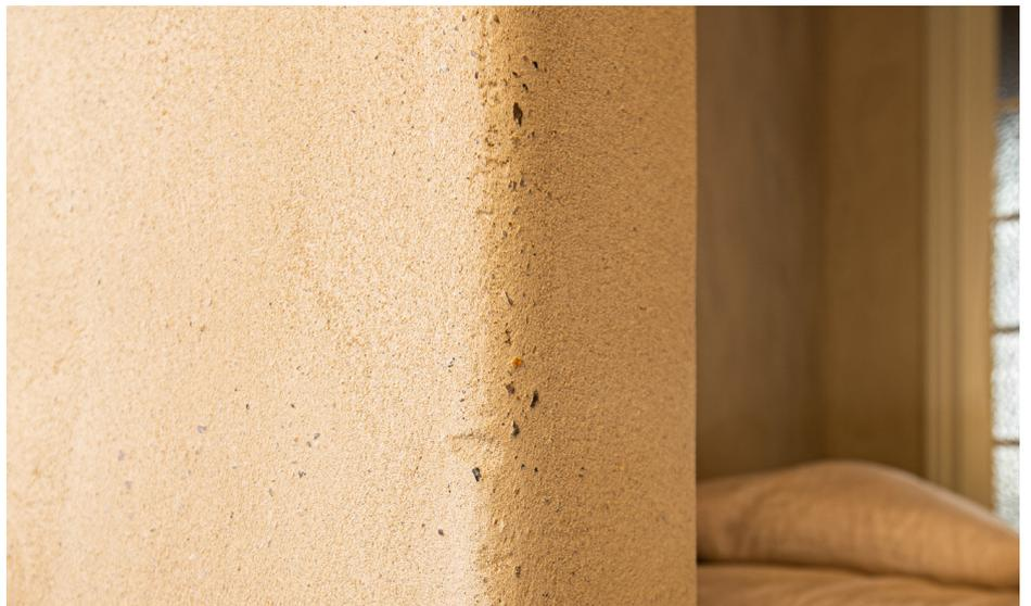
L'éponnage permet d'obtenir une surface homogène. Chez l'Enduit d'argile de Léém, des graviers peuvent également devenir plus visibles en fonction du moment et de l'intensité de l'éponnage.
