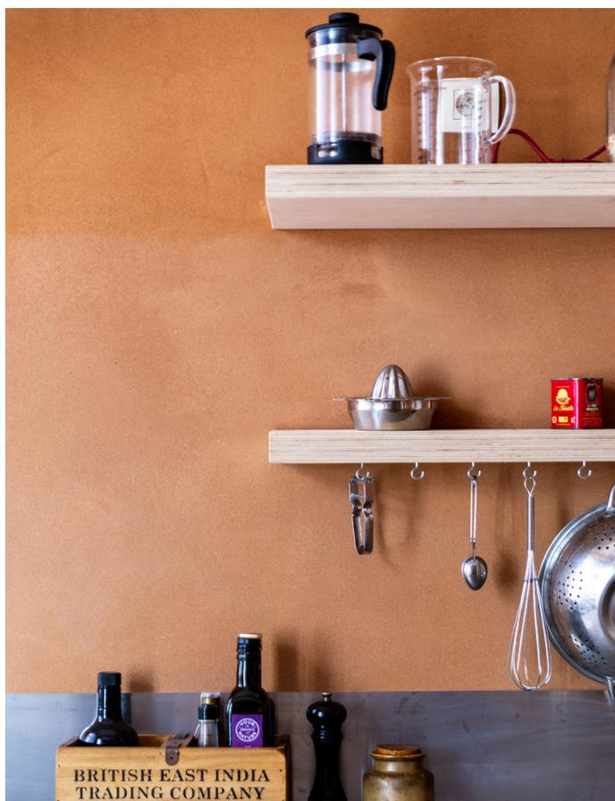
Enduit d'argile de Léém Rouge avec fixative contre les éclaboussures
