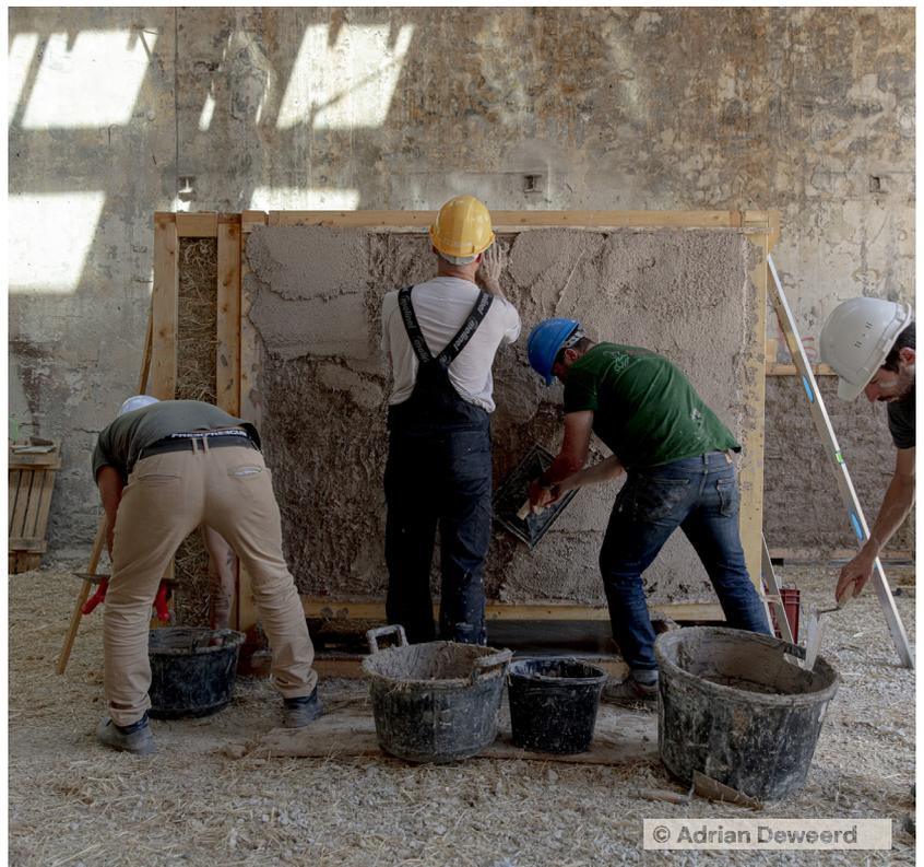
Prototype d'Enduit d'argile de Léém sur bottes de paille pour le projet Atelier Luma
