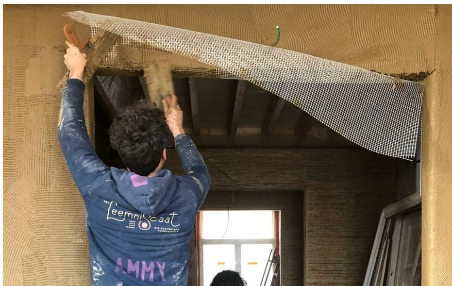
Tissu de renforcement noyé dans la couche de base, recouvrant le linteau
