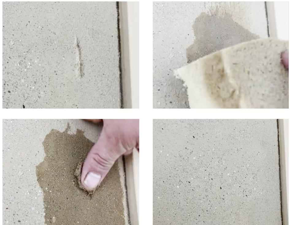
Processus de réparation d'un dommage dans un enduit d'argile de Léém épongé
