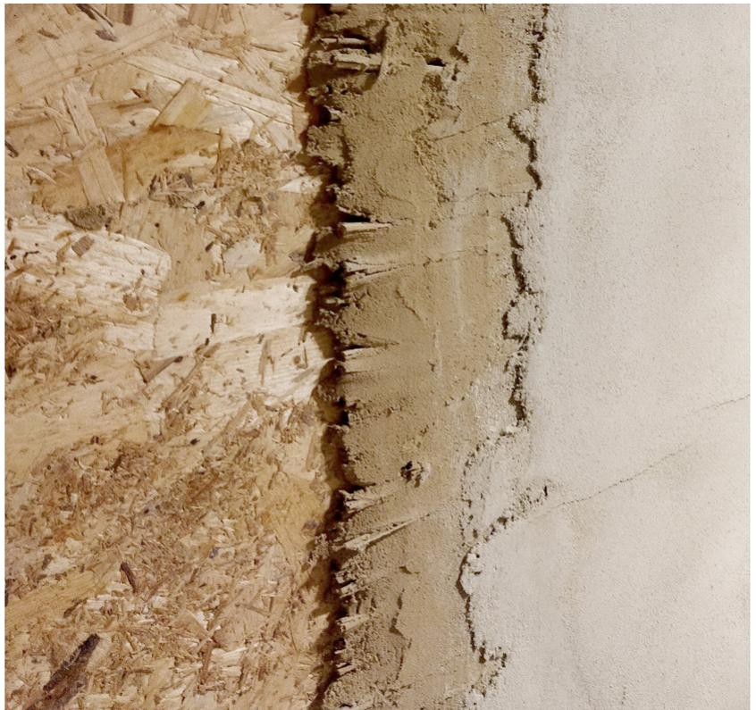
Panneaux OSB avec lattes de roseaux agrafées dessus. La latte de roseau doit être suffisamment recouverte (plus que sur cette image) pour créer une couche de base homogène et éviter les fissures.
