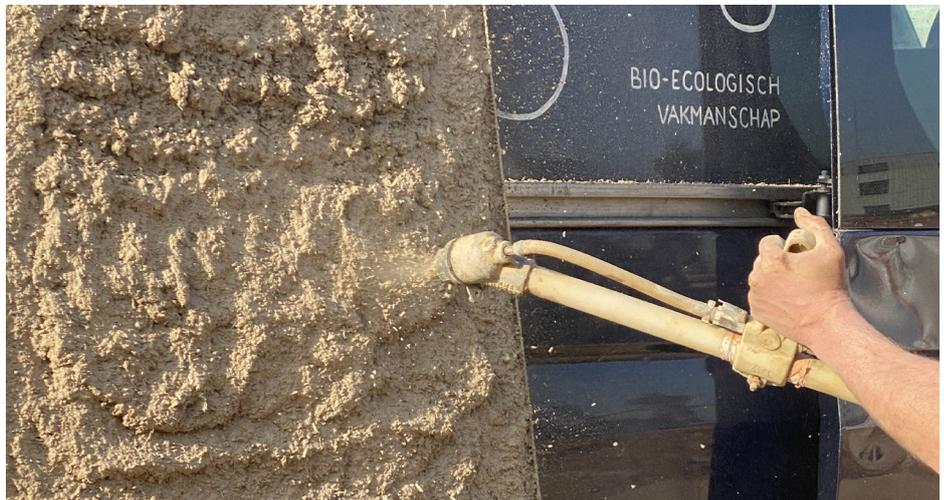
Enduit d'argile de Léém appliqué à l'aide d'une machine à projeter
