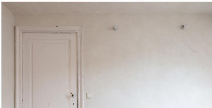
Une Peinture à l'argile de Léém a été appliquée sur l'Enduit d'argile de Léém, les plaques de plâtre et la peinture murale existante afin d'homogénéiser la texture et la couleur de l'espace.
