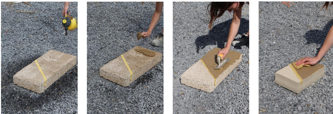
Illustration des différentes étapes de l'application de l'Enduit d'argile de Léém.
