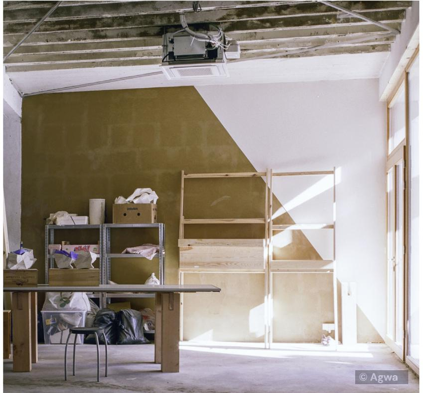
Une couche de base d'Enduit brun à l'argile de Léém montre les lignes fantômes des joints de maçonnerie. Pour les éviter, au moins deux couches d'Enduit d'argile (fin) de Léém sont nécessaires.
